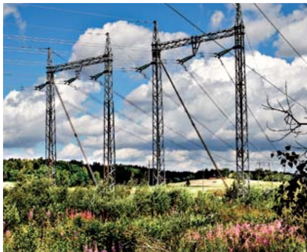
Harustettu kaksijalkainen teräspylvä
